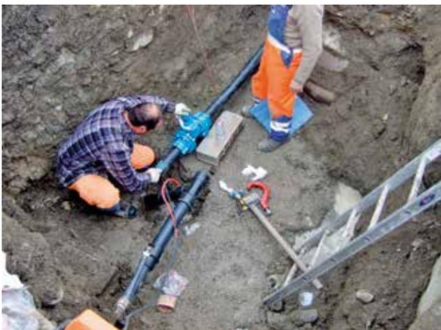
**Seit 2021** ist ganz Schluderns über ein modernes Verteilernetz mit der Trinkwasserquelle im Upital verbunden. Durch Ringleitungen ist es nun möglich, bei Bedarf einzelne Leitungsabschnitte abzusperrern, ohne dass die Trinkwasserversorgung im gesamten Dorf unterbrochen werden muss.
